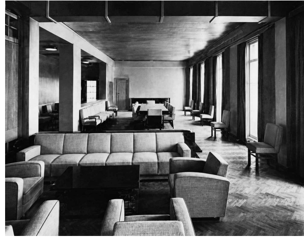
Şekil 15. Dışişleri Bakanlığı Misafirhanesi fümuar mekânı.
